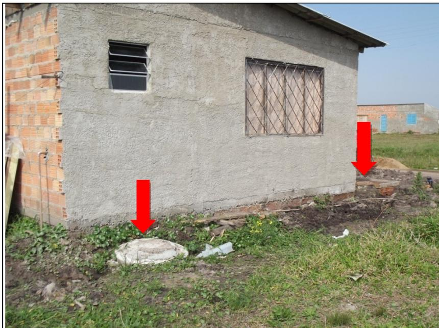
**Figura 18 - No destaque o sistema fossa séptica e sumidouro, respectivamente.**
