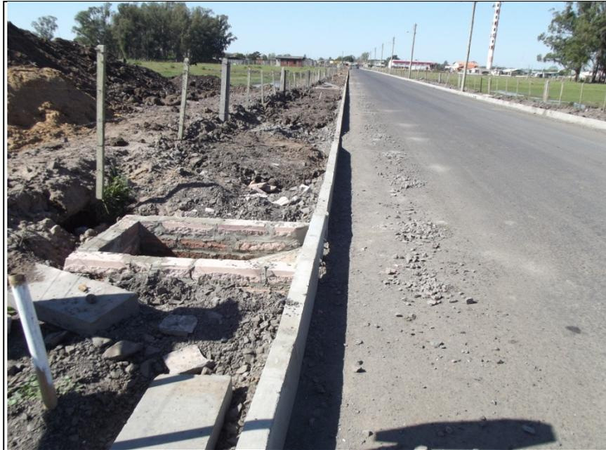
**Figura 23 - Pavimentação asfáltica sendo construída em via urbana da sede, já com canalização de drenagem urbana e com a boca de lobo instalada.**
