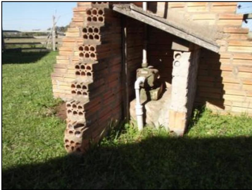
Figura 17 - Poço de ponteira.
