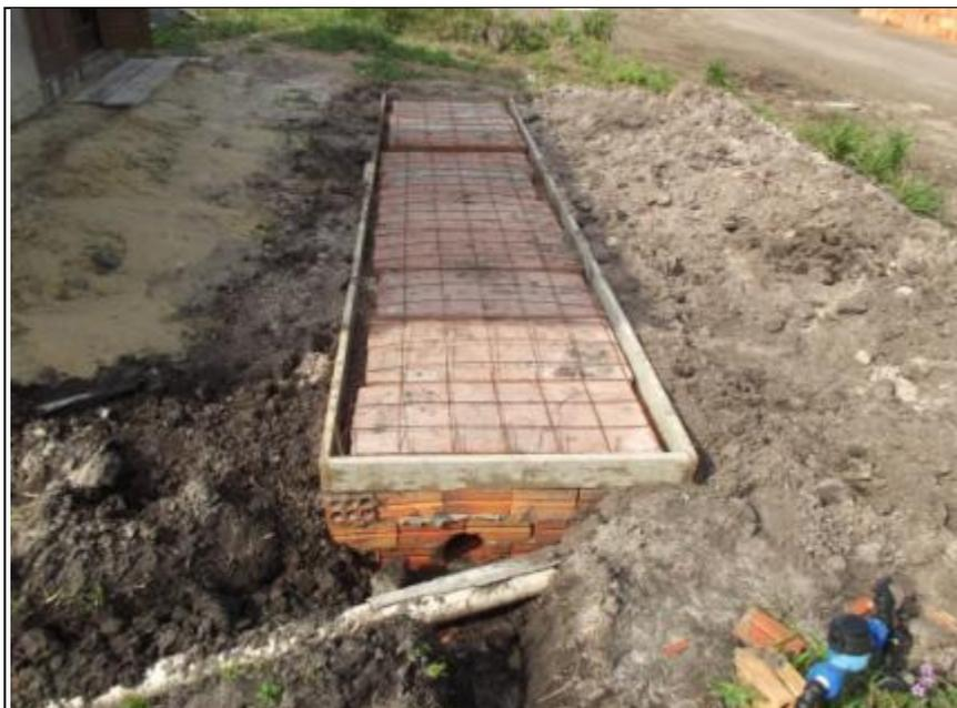
**Figura 20 - Sumidouro em construção, com tijolos de barro.**
