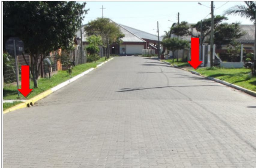
**Figura 22 - Pavimentação com blocos de concreto intertravados em via urbana da sede do município, também destaque para a construção das bocas de lobo.**
